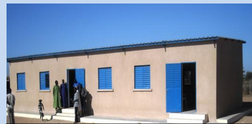
Blocs de salle de classe réalisée avec l'appui du Pndl à Nguene Sarr
